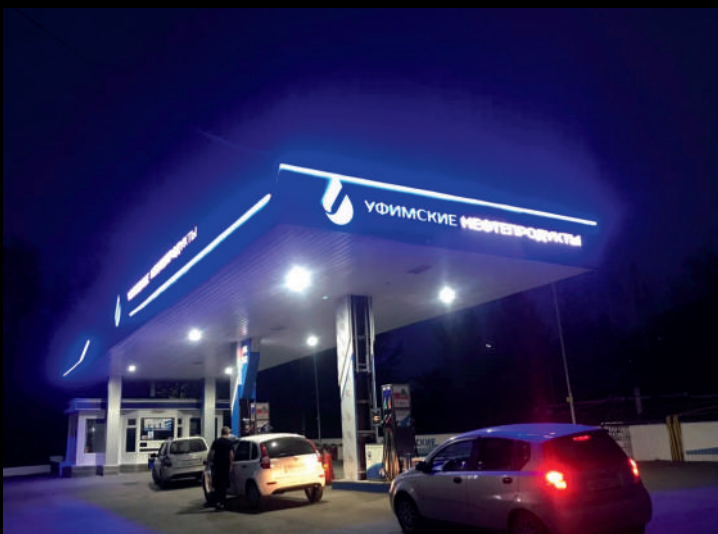
Функциональная и стильная подсветка фризоз автозаправочной станции ультратонкими архитектурными светильниками – эффектно и эффективно (г. Челябинск).
