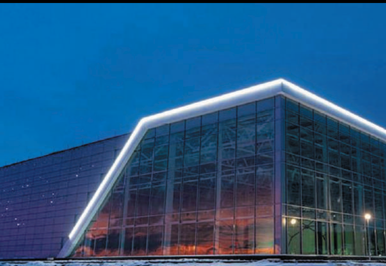
Геометричный светящийся контур и мерцающее «звездное небо» созданы с помощью архитектурных светильников и smart-модулей (г. Ханты-Мансийск).
